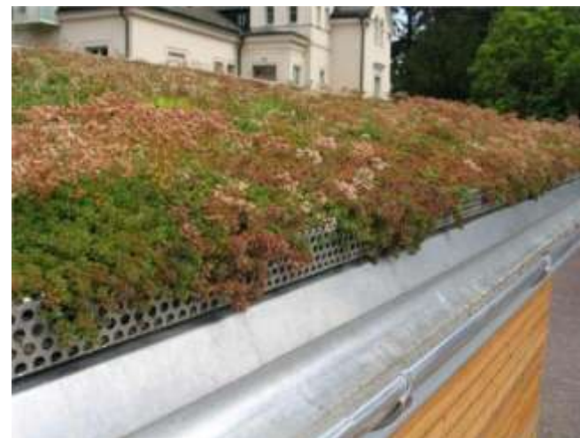
Vid takbeläggning med sedum anläggs denna på underlag av giftfri heltät duk. Bild från www.ekologiskabyggvaruhuset.se
