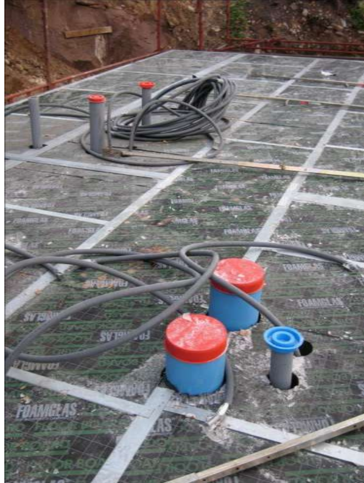
Minimal åverkan på mark (undvik sprängning), plus en radonsäker och energieffektiv grund med cellglas (här från Koljern).
