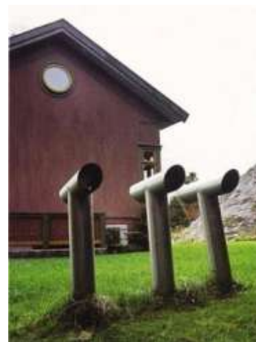
Exempel på intagshuv luft från Rehau.
