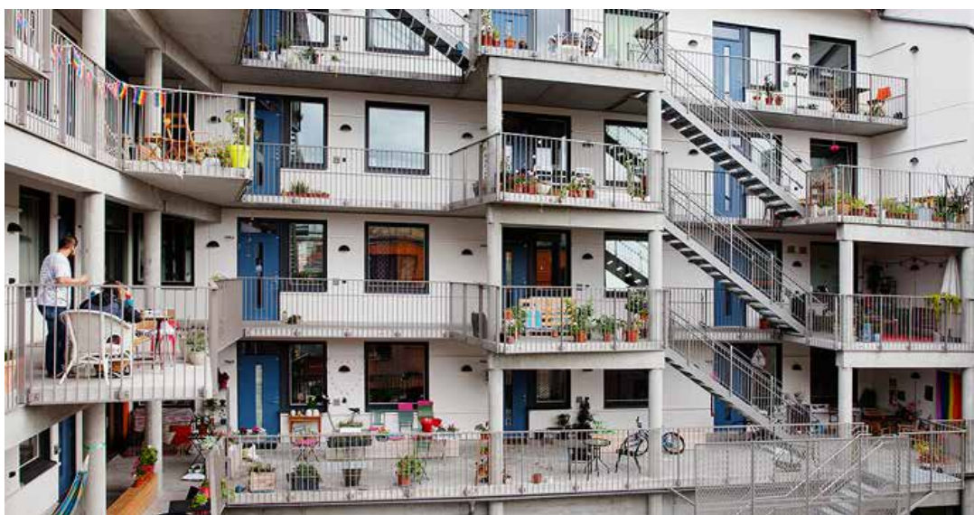
I Sofielunds kollektivhus i Malmö har tillgång till många gemensamma utrymmen som storkök och matsal för matlag, barnrum, TV-rum, musikrum, verkstäder, gästlägenhet, yogarum, bastu, innergård och en stor takterass! Foto Bojana Lukač. Arkitekt Kanozi.
