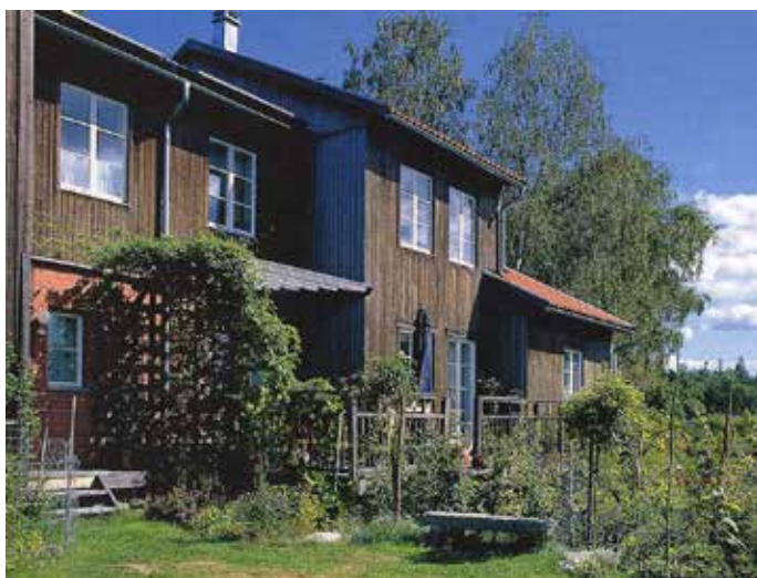
Byggemenskapen Ebba byggde husen tillsammans med Småa och HSB. De första familjerna flyttade in 1995. Området blev mycket uppmärksammat. BRF Understenshöjden i Björkhagen.
