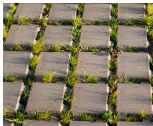
Gräsarmering som släpper igenom vatten. T. v. av återvunnen polyetenplast från Salsaverde, t. h. markbetong.
