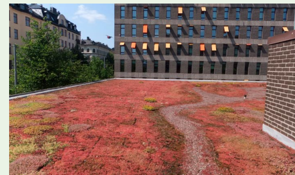
Ett par av de gröna tak som har undersökts.
