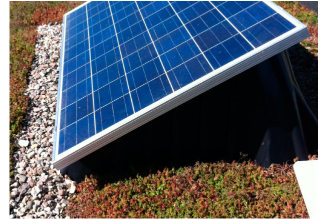
Solceller kan samordnas fint med etablering av ett grönt tak.
