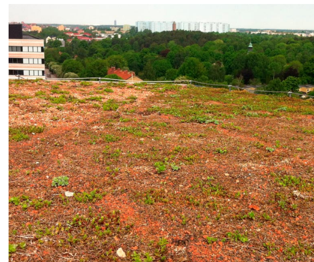
KI-aulan i Stockholm har ett sedumtak. Huvudmotivet till att välja grönt tak var att utjämna belastningen på dagvattennätet vid kraftiga regn. (Foto: Eva Sikander)
