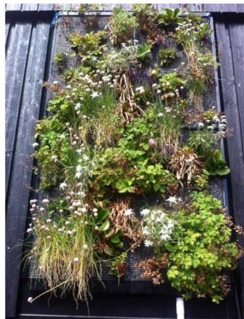
Figur 1. Uppbyggnad av växtkassetter utanpå befintlig vägg.
