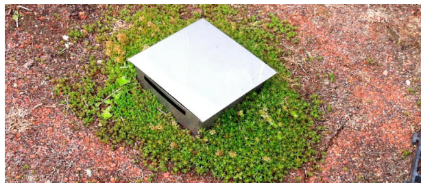
Projektering av brunnar och genomföringar är viktiga för att undvika risk för läckage. Fuktsäkerhetsprojektering ska dokumentera fuktsäkra lösningar. (Foto: Eva Sikander)
